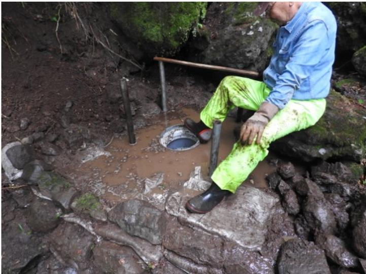
取水口設置場所は沢の中で大きな岩がありそれを二個取り除いて少し斜めに（下流側）設置した。下流部に土嚢と石で堤防を作り、ダムを造った。漏水箇所があったが、泥と小石で止水できた。今後は上流からの流水で徐々に止水できると思う。取水口の上に落ち葉が入らないように単管を4本立てて、シートを貼るように工夫してある。
